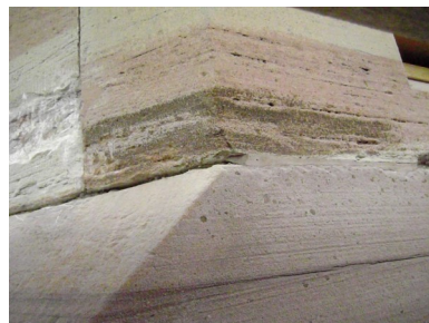
Bild 6: Maserung/Lagerschichten
