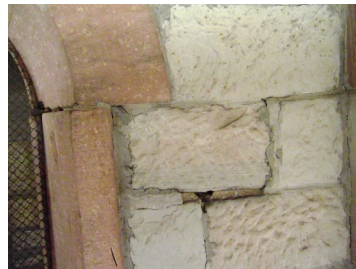
Bild 5: Zementfugen
