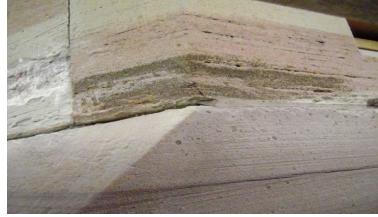
Bild 3: Alte Mörtelergänzungen
